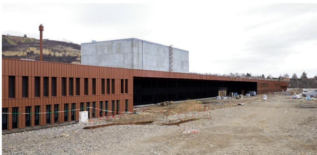
Photo : chantier de la nouvelle imprimerie de la Banque de France à Vic-le-Comte, 2026
